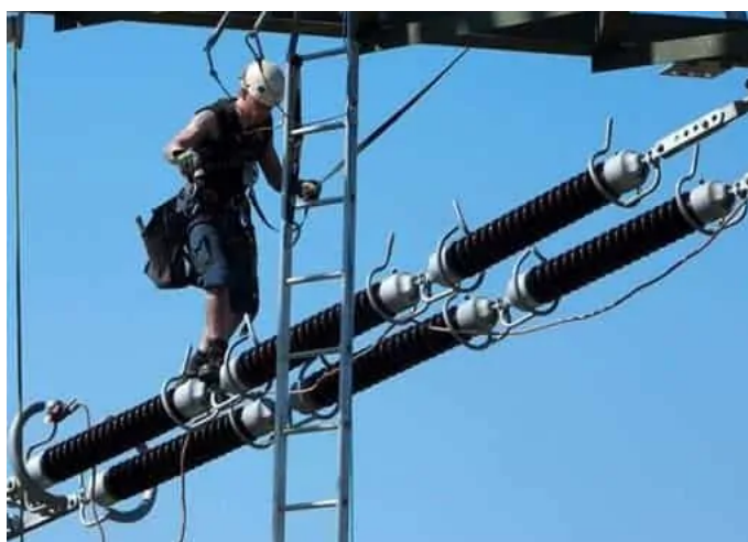
Slika 2.17: Višestruki štapni izolator
